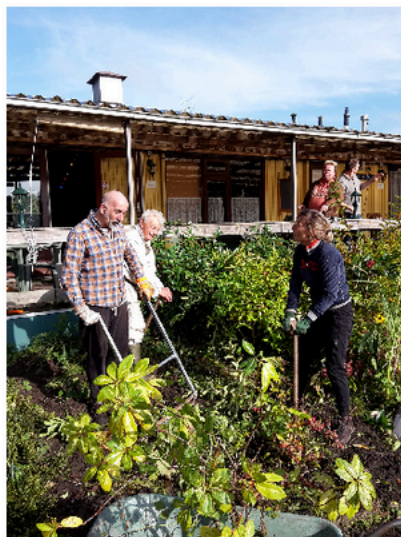
Voorbereiding renovatie talud en terrastrap door Francois, Bianca en Frans onder toezicht van Roland.
